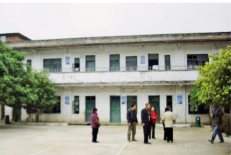
廣西梧州藤縣新慶鎮中心小學的南教學樓正待重建。
