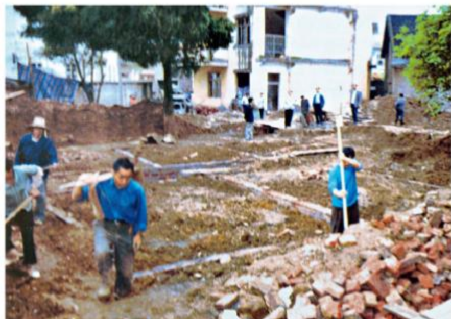
粵北「新亞醫院」動工。
