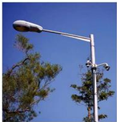
▲鏡頭監測器安裝燈柱上，採用鳥瞰式角度拍攝，既可避開強光照射，又可保障車廂內人士的私隱。
