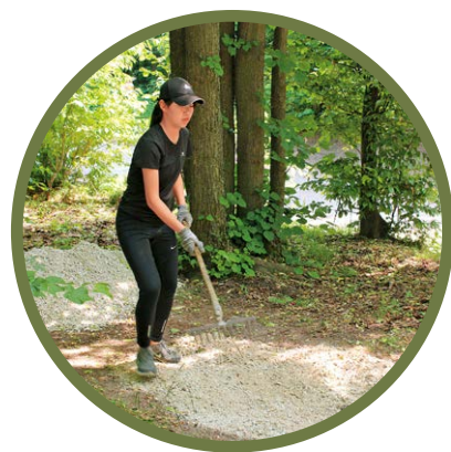
▲ 在匈牙利做義工，幫助當地人清除雜草和修建山路。
